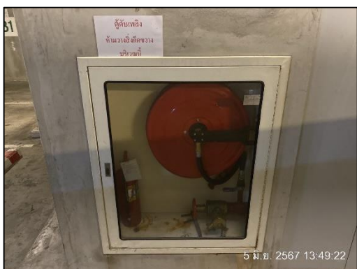
ภาพที่ 20 ถังดับเพลิง/ป้ายแนะนำการใช้อุปกรณ์
